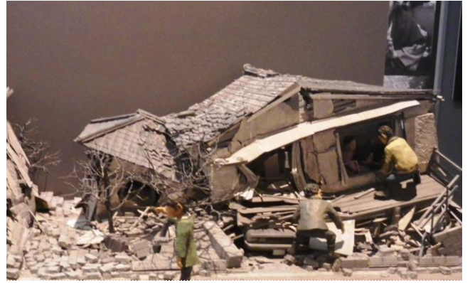
(上) 阪神・淡路大震災の原因となった地震で1階部分が潰れ倒壊した家屋のジオラマ
